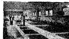
急速濾過槽（米國）
