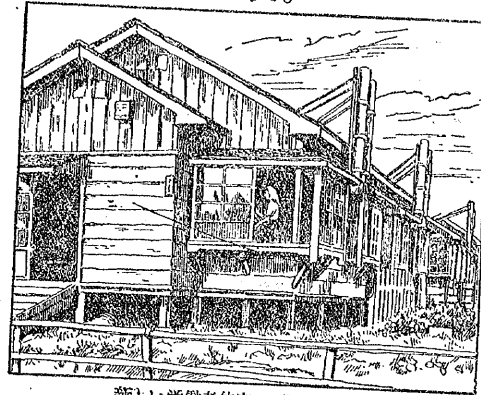
新しい労働者住宅 一北海道炭坑一
