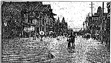
水害(上) 昭和十年六月二十九日朝、京都では夜來の豪雨で加茂川が溢れ、三條、五條等大多數の橋は落ち、河津各所に浸水した。同は四條通市座前の光景である。
