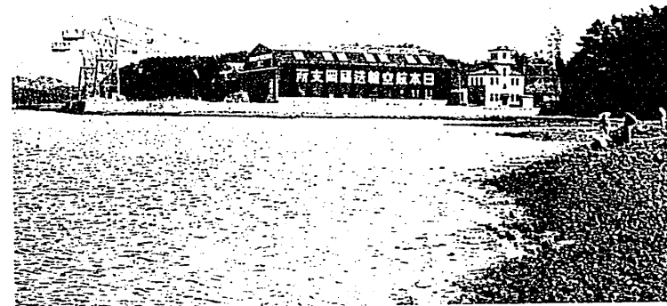
あて場行飛上水際関るす處に局空航省信通るあに島名宇村良々多外市岡福 場行飛島名 てしと場行飛上水く少波風めたるあで海内で帯一面水り寄東灣多博は域區走沿上水 る のもふ運に庫納格け上り吊を機行飛りよ上水で式塔定固底一は機重起の圖 るあで適最 るあで
