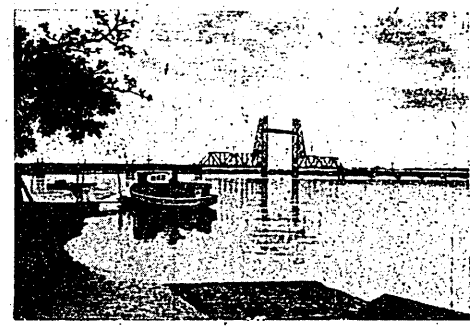
道鐵の式開昇る架に(線實佐)流下の川後筑 川後筑(四)るなと係軌てつ降に下が桁はに時る通を處此が車列で橋
