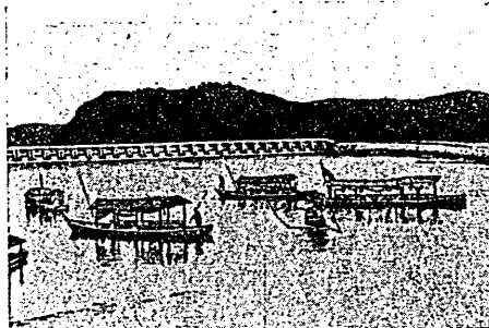
宇治川の洗堰 二十三の門水を設け水量を調節する
