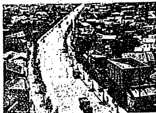
近代的道路の一例(京濱國道)
